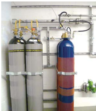
Рис. 6. Установка пожаротушения «Sinorix™ H 2 O Gas» (изготовитель — «Siemens», Швейцария)
